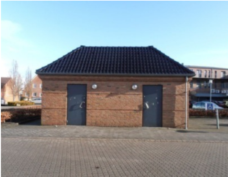
Foto af det offentlige toilet som er velfungerende på Nørregade 7
