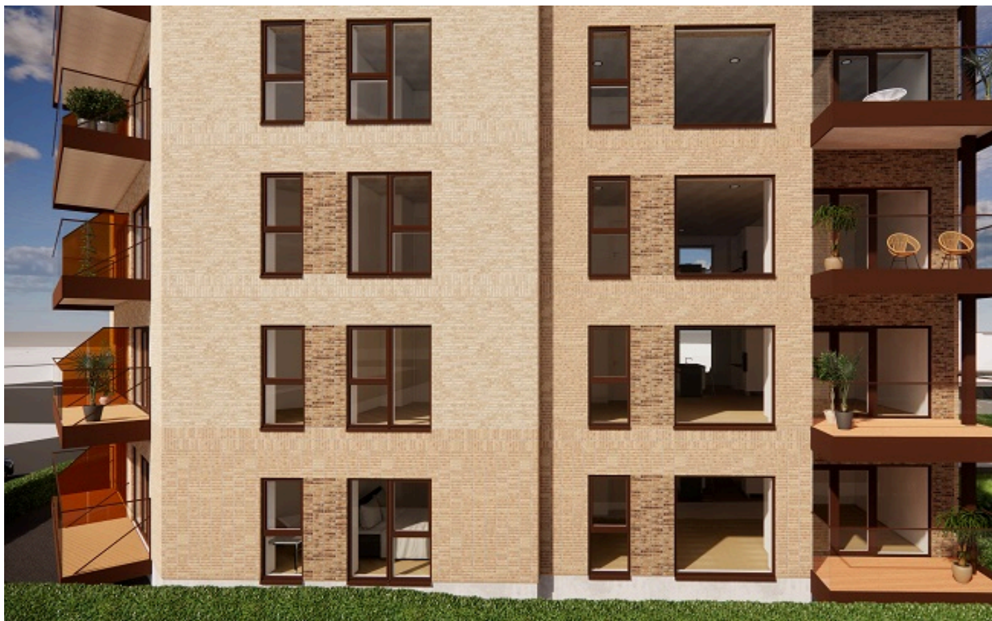
Figur 2. Billedet viser, hvordan de tre tegltyper bliver anvendt i facaderne
