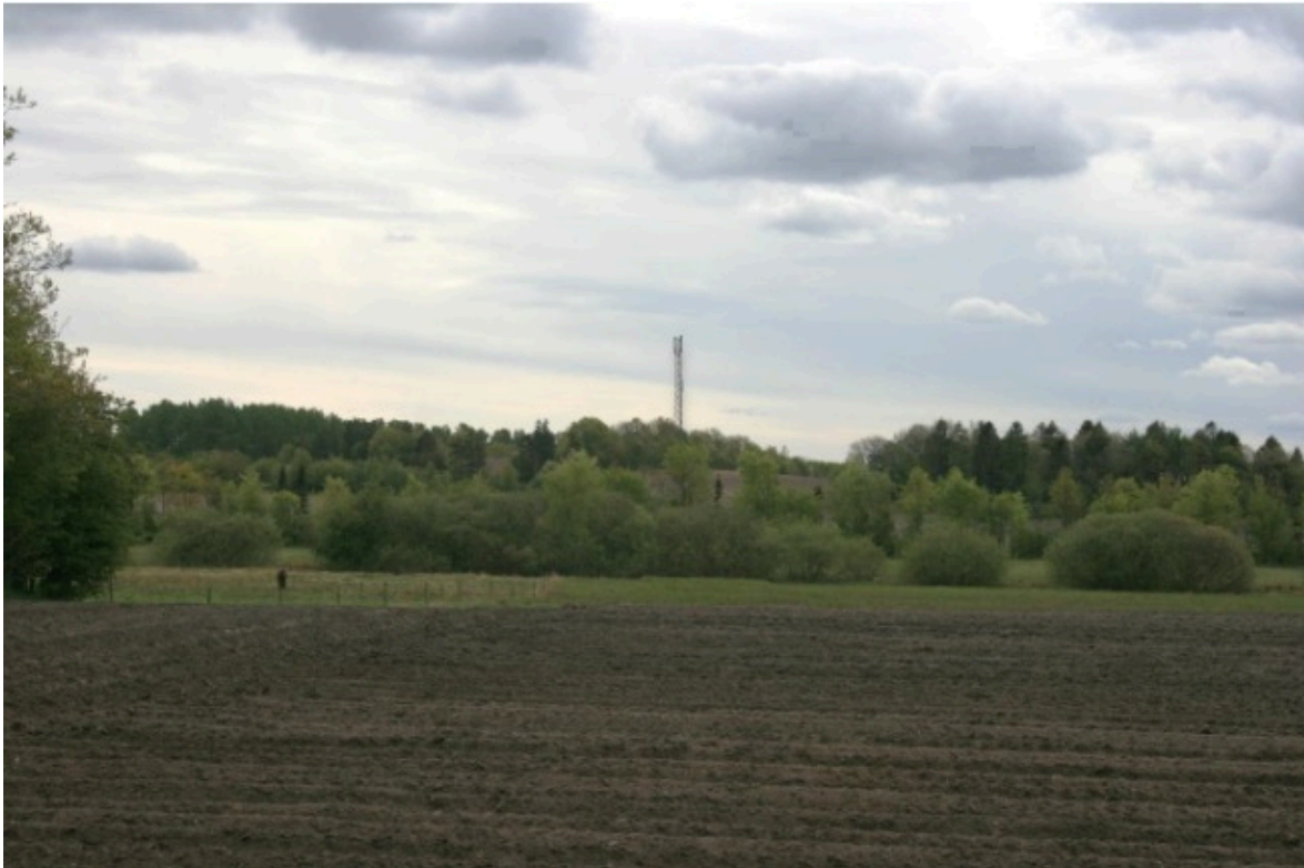
Illustration fra ansøger af bakkeøen set fra Tyvkærvej efter den ansøgte antennemast er opstillet.
