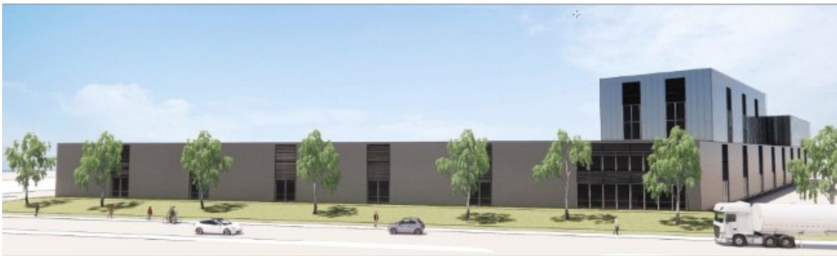
Visualisering indsendt af KMC, visende facaden mod Herningvej. Den høje lagerbygning ses bagerst til højre.
