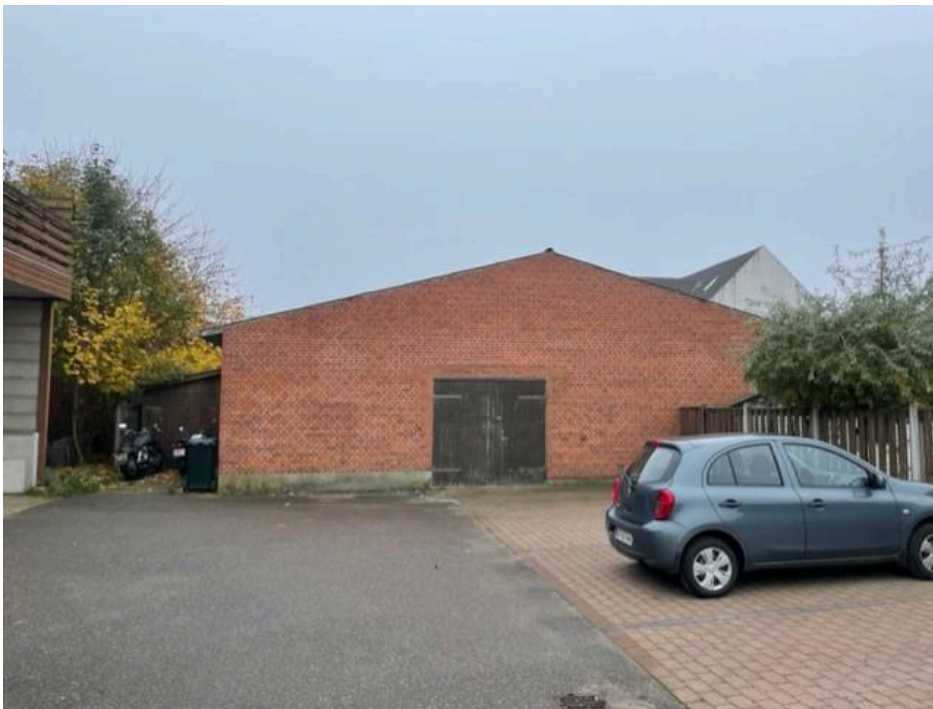
Eksisterende facade mod nord.
